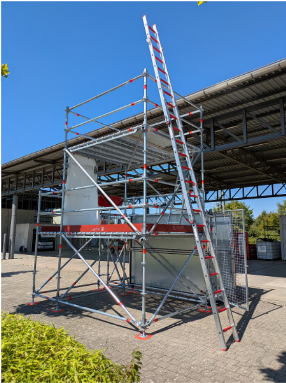
Abbildung 9: Beispiel Anleitern an einem Übungsgerüst
