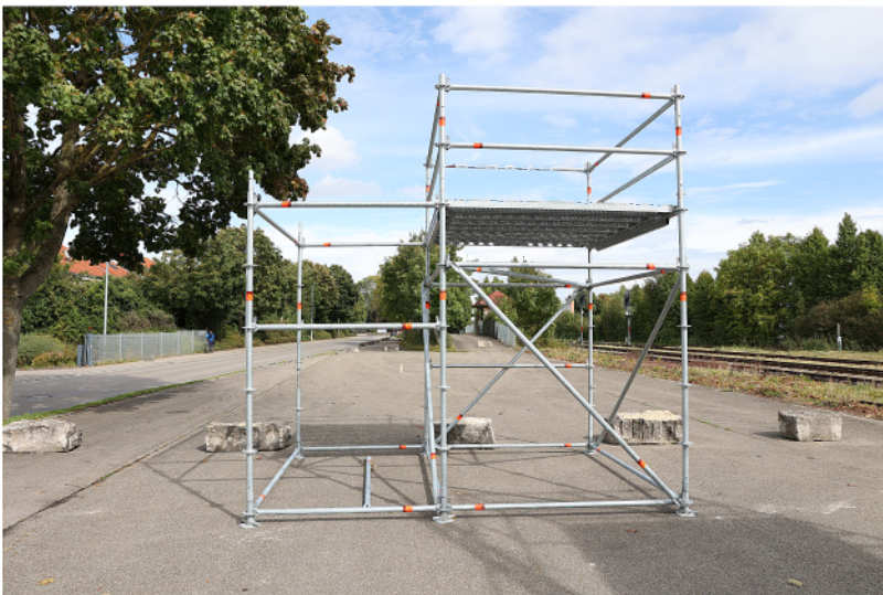
Abbildung 10: Übungsgerüst mit 1. OG
